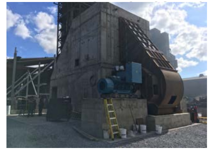
Dépoussiéreur de la hotte de toit à Contrecoeur-Ouest
