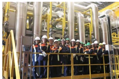
3 nouveaux fours de réchauffe : Contrecoeur Est-Ouest et Longueuil
