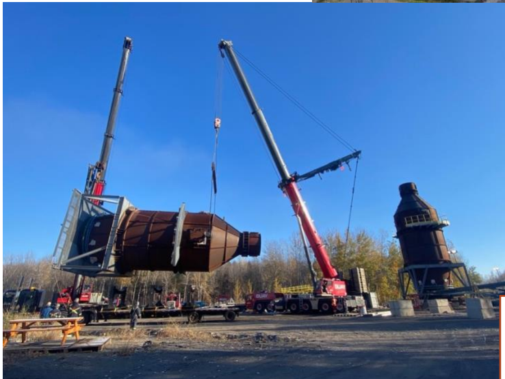
Travaux d'aménagement du nouveau système de gestion des poussières (octobre 2020).
