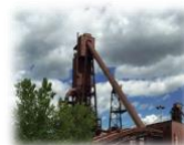
Usine de réduction
